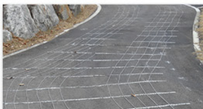
Завершение дорожной укладки
