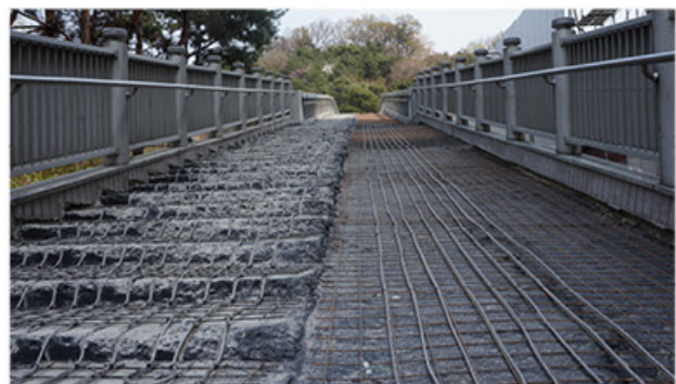
Мост(переходной мост и т.д.)
