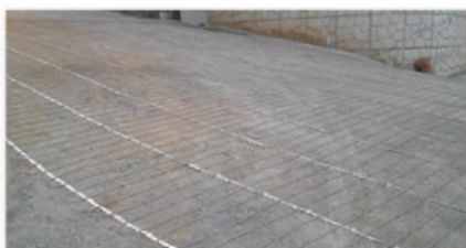
Завершение укладки на крутых склонах
