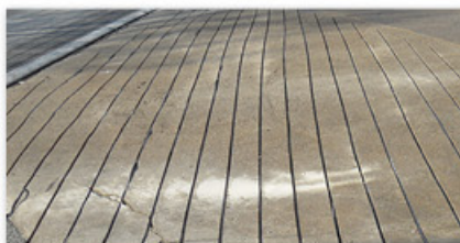
Завершение дорожной резки
