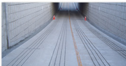
Завершение резки въезда в туннель
