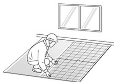
3 Установка проволочной сетки
