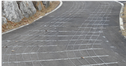
도로 포설 완료
