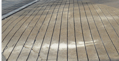
도로 커팅 완료
