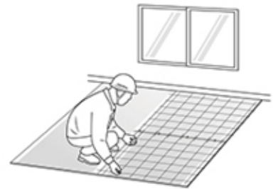
③ 와이어매시 설치
