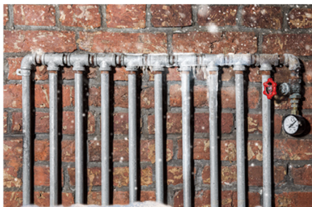
様々な外部の露出配管
