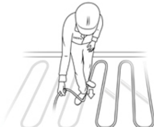
⑤ 暖房配管の挿入
